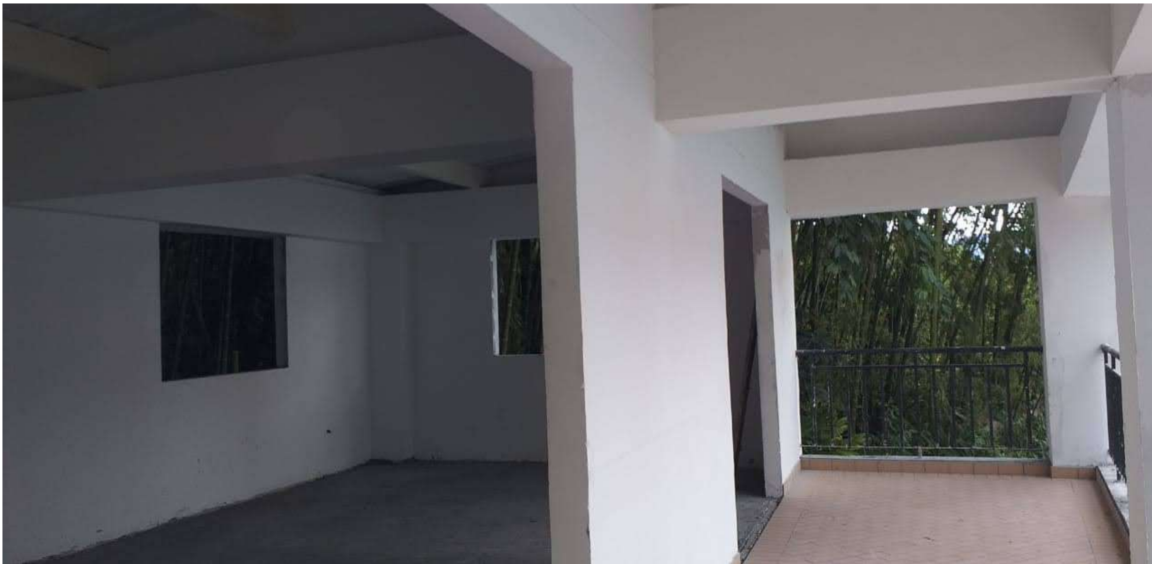
Parte interna gimnasio Etapa II
