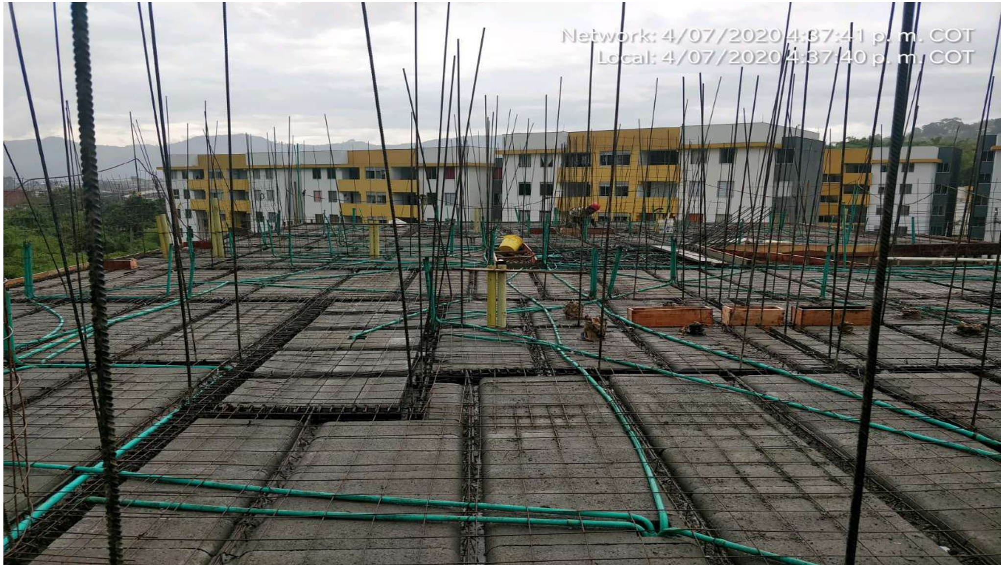
Estructura Etapa III
