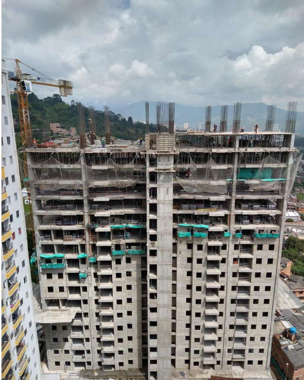
Mampostería interna piso 12 torre 3 y de fachadas torre 3 piso 10
