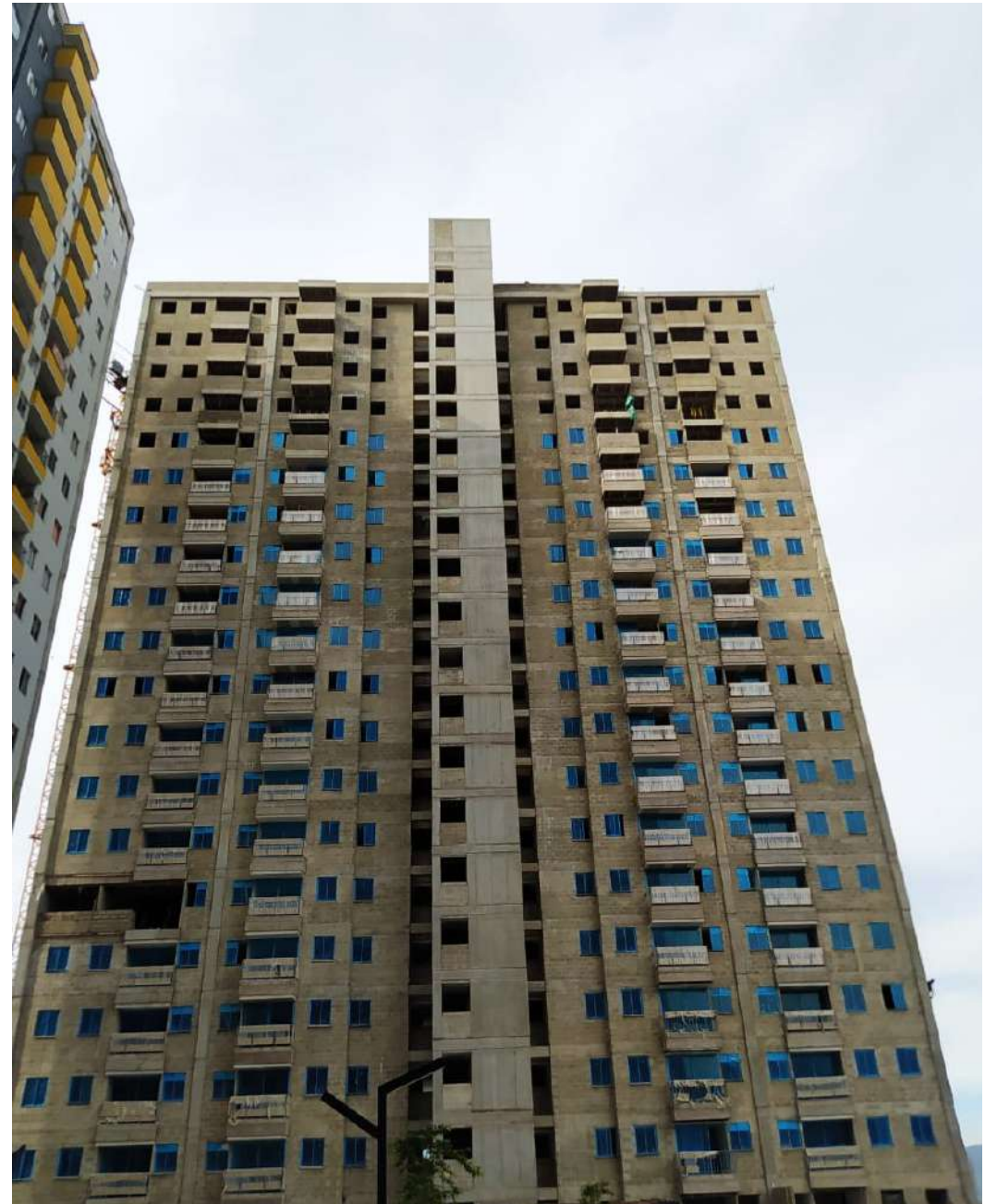
Estructura torre 3 terminada, con avance de ventanería y pasamanos
