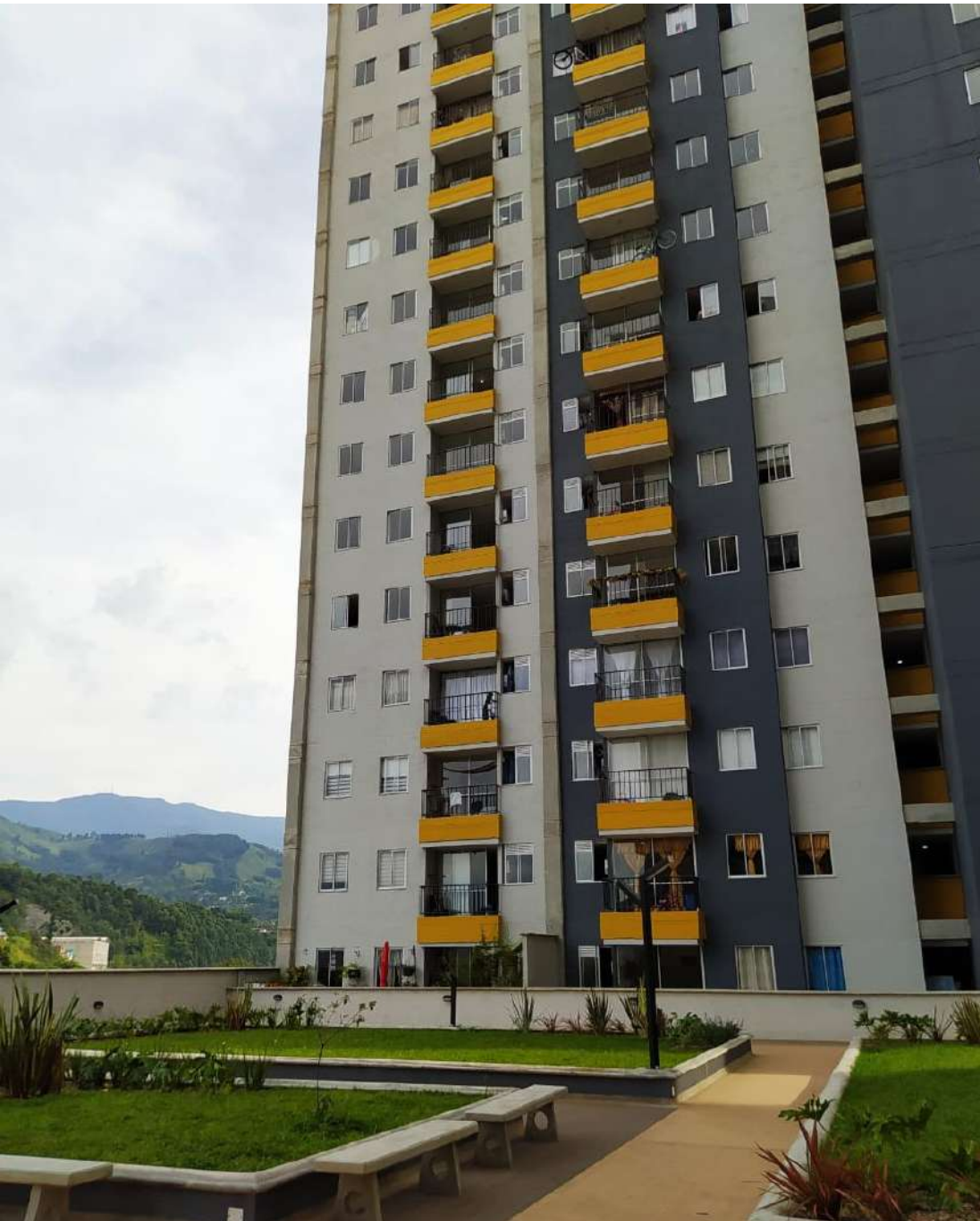
Plataforma con paisajismo terminado
