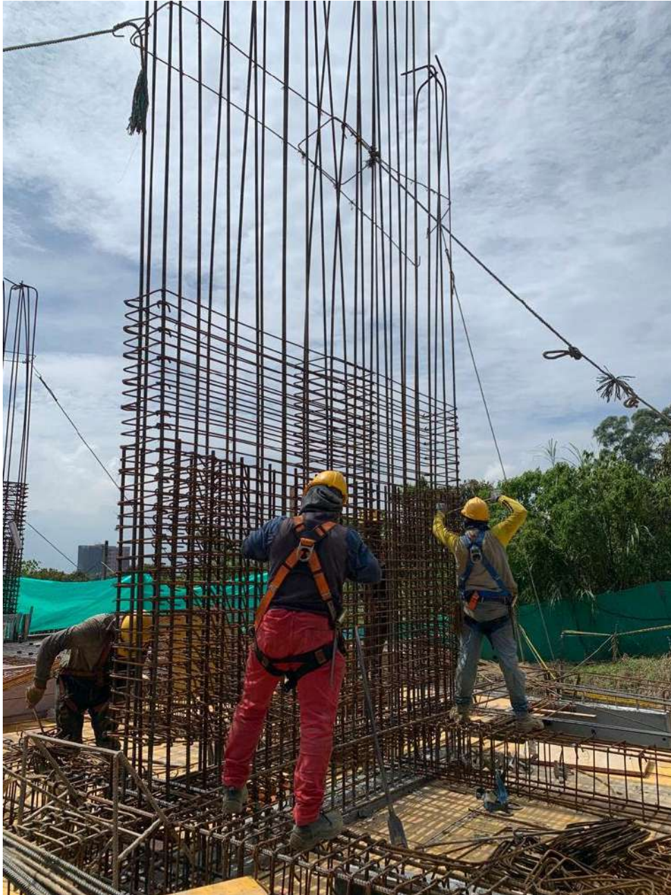
COLOCACIÓN ACERO EN COLUMNAS
