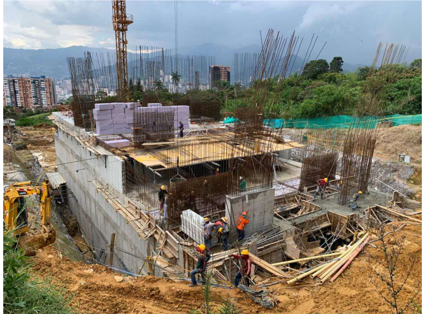
AVANCE DE ESTRUCTURA
